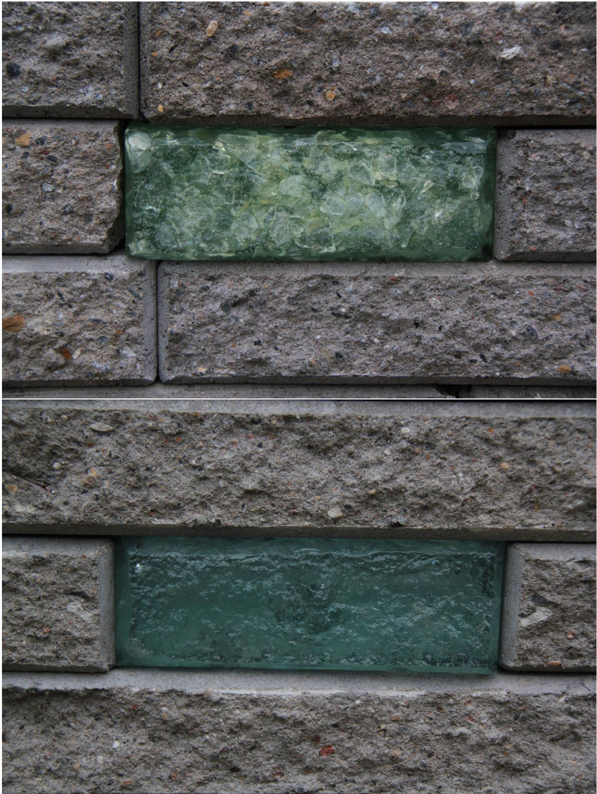
Ülemine valguskivi on paigaldatud umbes kolm nädalat tagasi. Alumine viimasel nädalavahetusel. Näha on, et mingi asi on mõjutanud lampi, et see on muutnud värvi ning ka valgustusomadusi.
