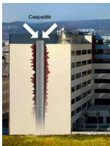
Vertikaalne korterelamu kuivendustoru
